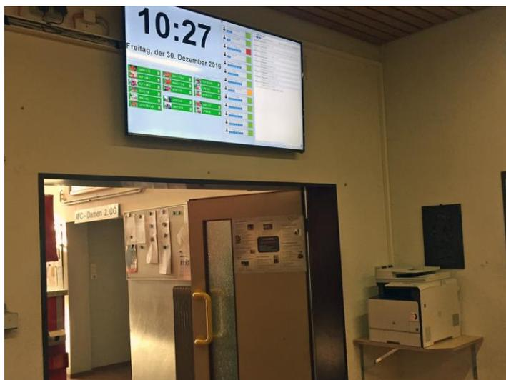
Im Umkleideraum zeigt ein **Einsatzmonitor** das Alarmstichwort, die laut AAO ausrückenden Fahrzeuge sowie die Verfügbarkeit der Gruppenführer an. Mit dem **Drucker** am Ausgang wird für jedes Fahrzeug der Anfahrtsweg ausgedruckt.
