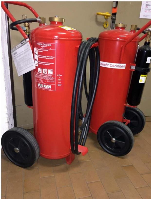
Im Lager stehen zwei **fahrbare 50kg-Pulverlöscher (ABC)** bereit. Sie sollen zur Sicherstellung des dreifachen Brandschutzes beim Gefahrguteinsatz mit dem GWT2 zur Einsatzstelle transportiert werden.
